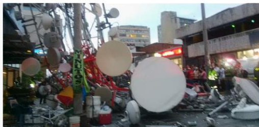
Foto: Archivo particular La estructura, de unos 15 metros, se desplomó por las fuertes lluvias.
