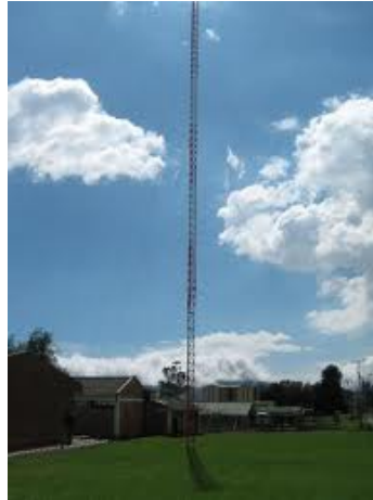
Figura 16: Torre templeteada - riendada
