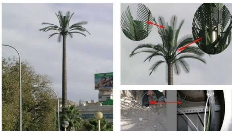
Figura 14: Foto Microcelda, cruce de vías
