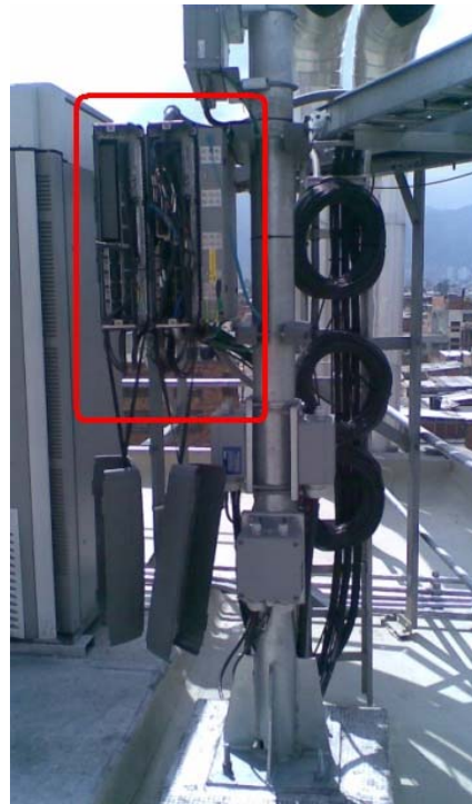
Figura 21: Unidad de Nodo B de UMTS Outdoor
