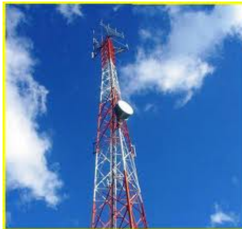
Figura 15: Torre autoportada para la colocación de una antena
